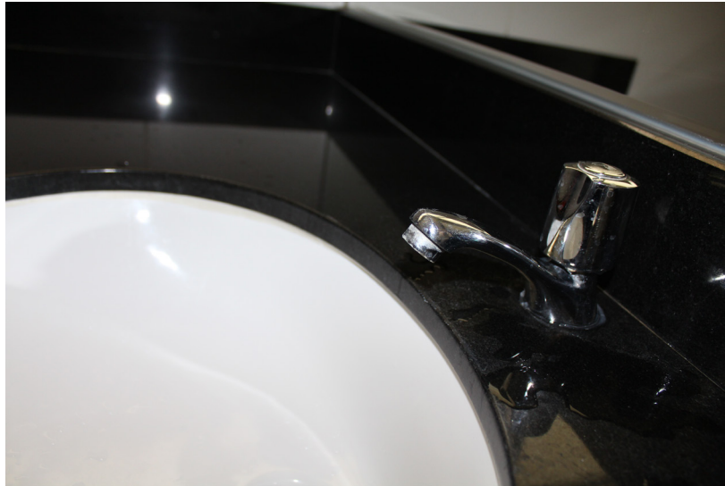
Grifería inaccesible (tipo rosca).
